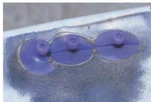
Ремонт емкости из стали
